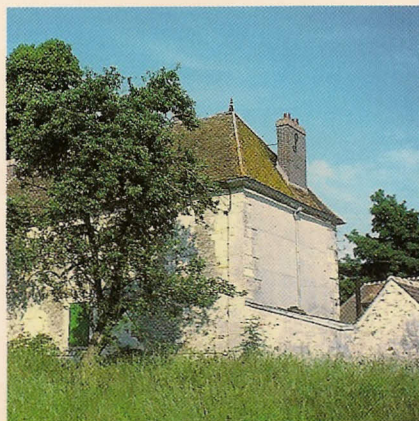
Maison enduite plâtre et chaux.
